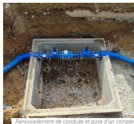
Renouvellement de conduite et pose d'un compte de sectorisation pour rechercher les fuites
