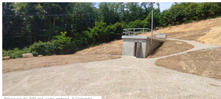
Réservoir de 200 m3, semi-enterré à Colombe
