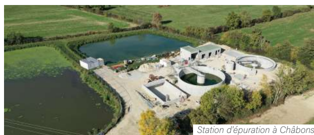
Station d'épuration à Châbons
